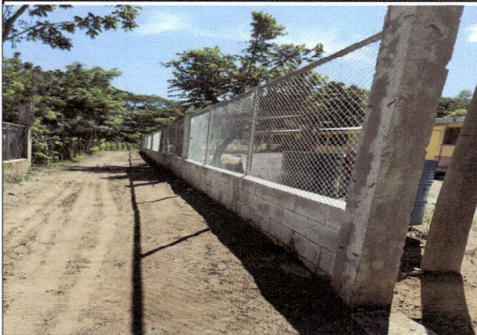
Foto 1: EL MEJORAMIENTO DE CERRAMIENTO DEL MURO PERIMETRAL FINALIZADO
