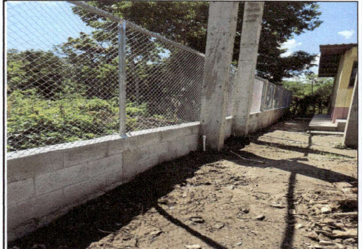
Foto 2: EL MEJORAMIENTO DE CERRAMIENTO DEL MURO PERIMETRAL FINALIZADO
