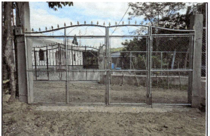
Foto 4: EL PORTON DE INGRESO DE LOS ESTUDIANTES FINALIZADO.
