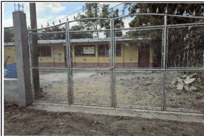
Foto 3: EL PORTON DE INGRESO DE LOS ESTUDIANTES FINALIZADO.
